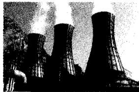
水在其中冷却后可重复使用, 从而实现热电系统循环水的零排放.
